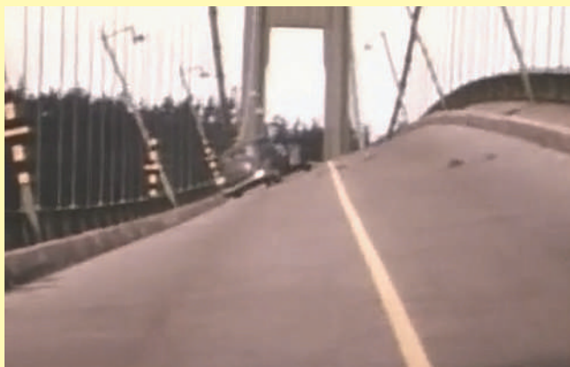
Разрушение висячего моста на реке Такома Нерроус (США)
